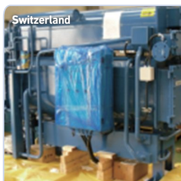
Zentralwascherei HWAR-L 50usRT(176kW)
